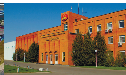
Цех Сады Придонья, г. Волгоград
